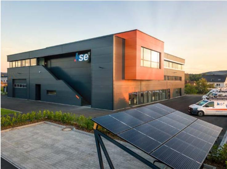
Das innovative Konzept des Installationsbetriebs Klaus Schleicher Energietechnik, kurz KSE, in Eichenzell bei Fulda verbindet Solarkraft mit einem starken Gewerbespeicher, etlichen Ladepunkten sowie Infrarotheizung. Was man nicht sieht: Ein multifunktionales Speichersystem übernimmt das Lademanagement der E-Fahrzeugflotte und die Verbrauchsoptimierung.
