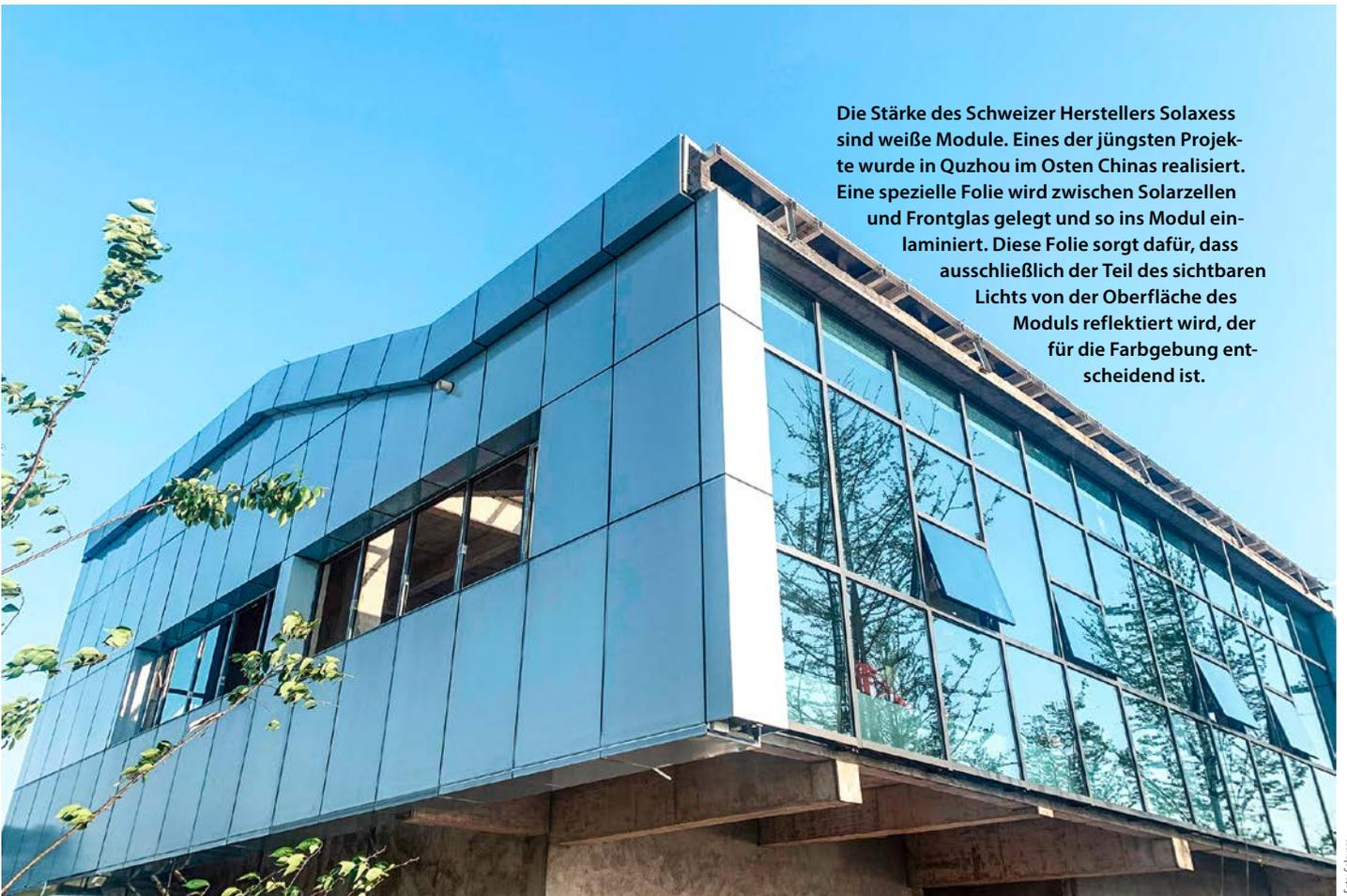
Die Stärke des Schweizer Herstellers Solaxess sind weiße Module. Eines der jüngsten Projekte wurde in Quzhou im Osten Chinas realisiert. Eine spezielle Folie wird zwischen Solarzellen und Frontglas gelegt und so ins Modul einlaminiert. Diese Folie sorgt dafür, dass ausschließlich der Teil des sichtbaren Lichts von der Oberfläche des Moduls reflektiert wird, der für die Farbgebung entscheidend ist.
