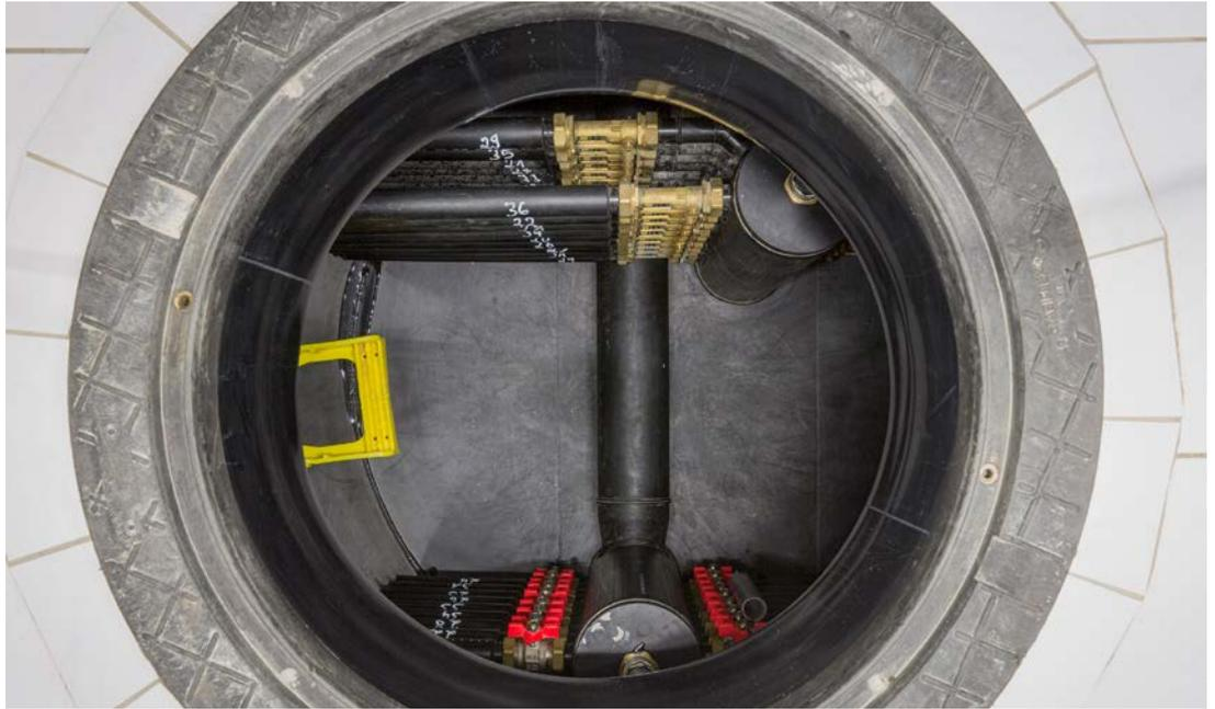
**Blick in den Betonschacht mit der hydraulischen Verteilung für die Erdsonden.**
