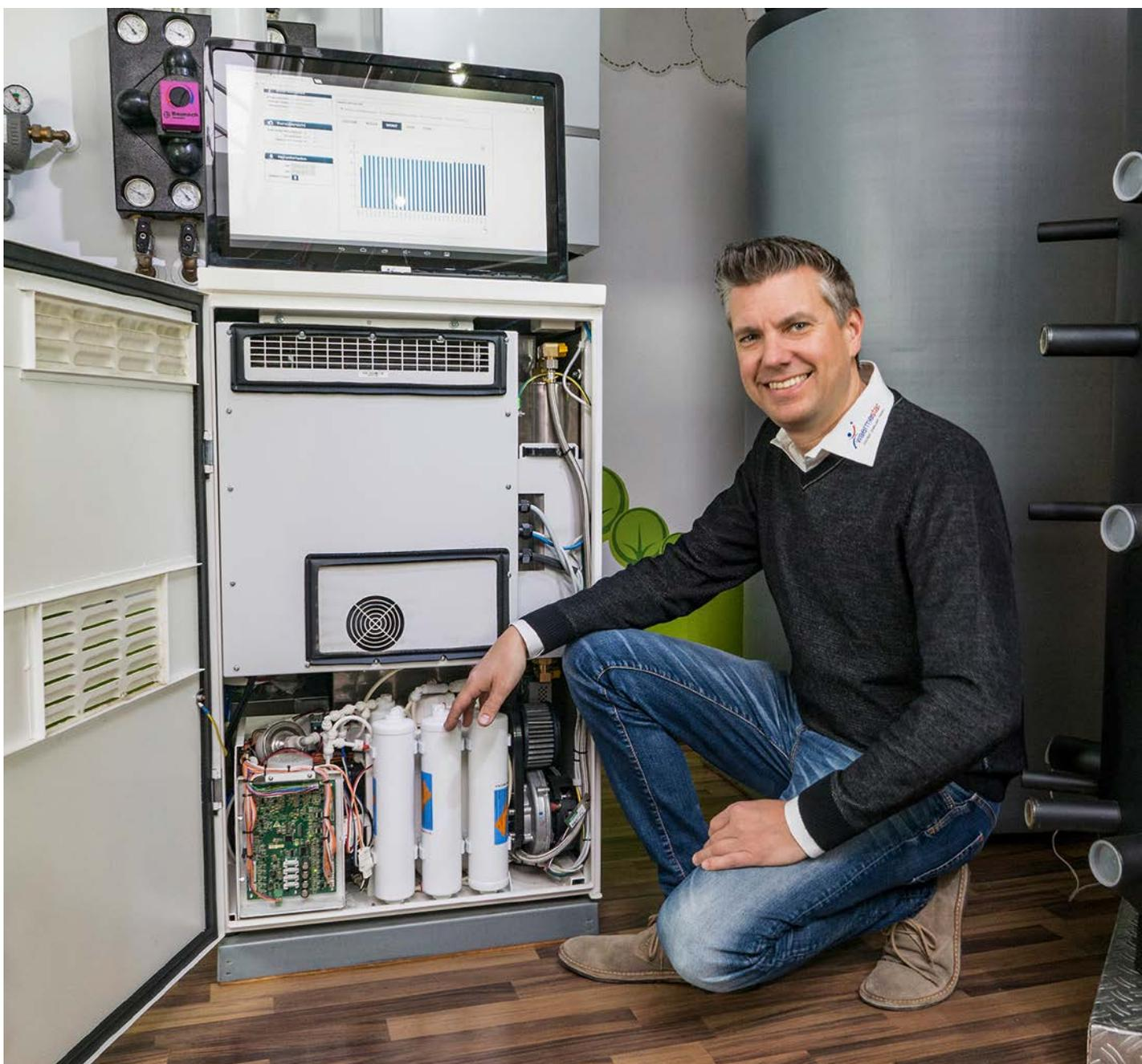
Dieses Brennstoffzellengerät hat eine elektrische Leistung von 1,5 Kilowatt. Es kann im Jahr rund 13.000 Kilowattstunden erzeugen – aus Erdgas.
