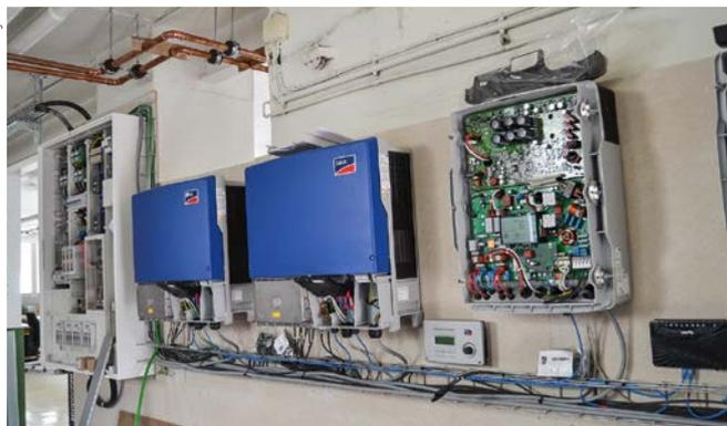
**Kaskade von Solarumrichtern in einem Unternehmen in Stuttgart. Der rechte Umrichter ist zu Prüfzwecken geöffnet.**
