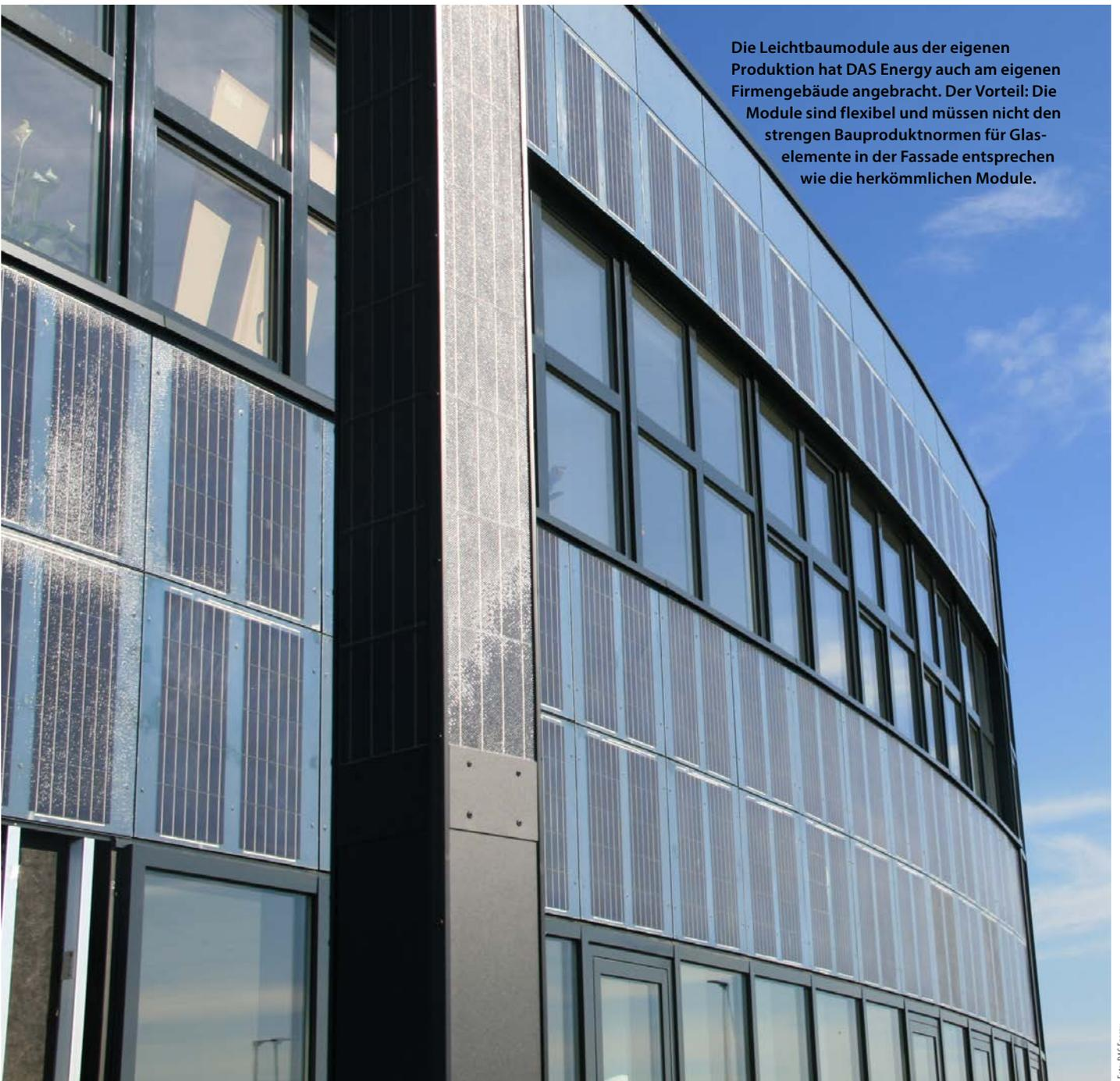
Die Leichtbaumodule aus der eigenen Produktion hat DAS Energy auch am eigenen Firmengebäude angebracht. Der Vorteil: Die Module sind flexibel und müssen nicht den strengen Bauproduktnormen für Glaselemente in der Fassade entsprechen wie die herkömmlichen Module.
