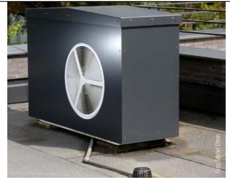
**Splitgerät zur Dachaufstellung: Es versorgt eine kleine Luftwärmepumpe für ein Einfamilienhaus.**
