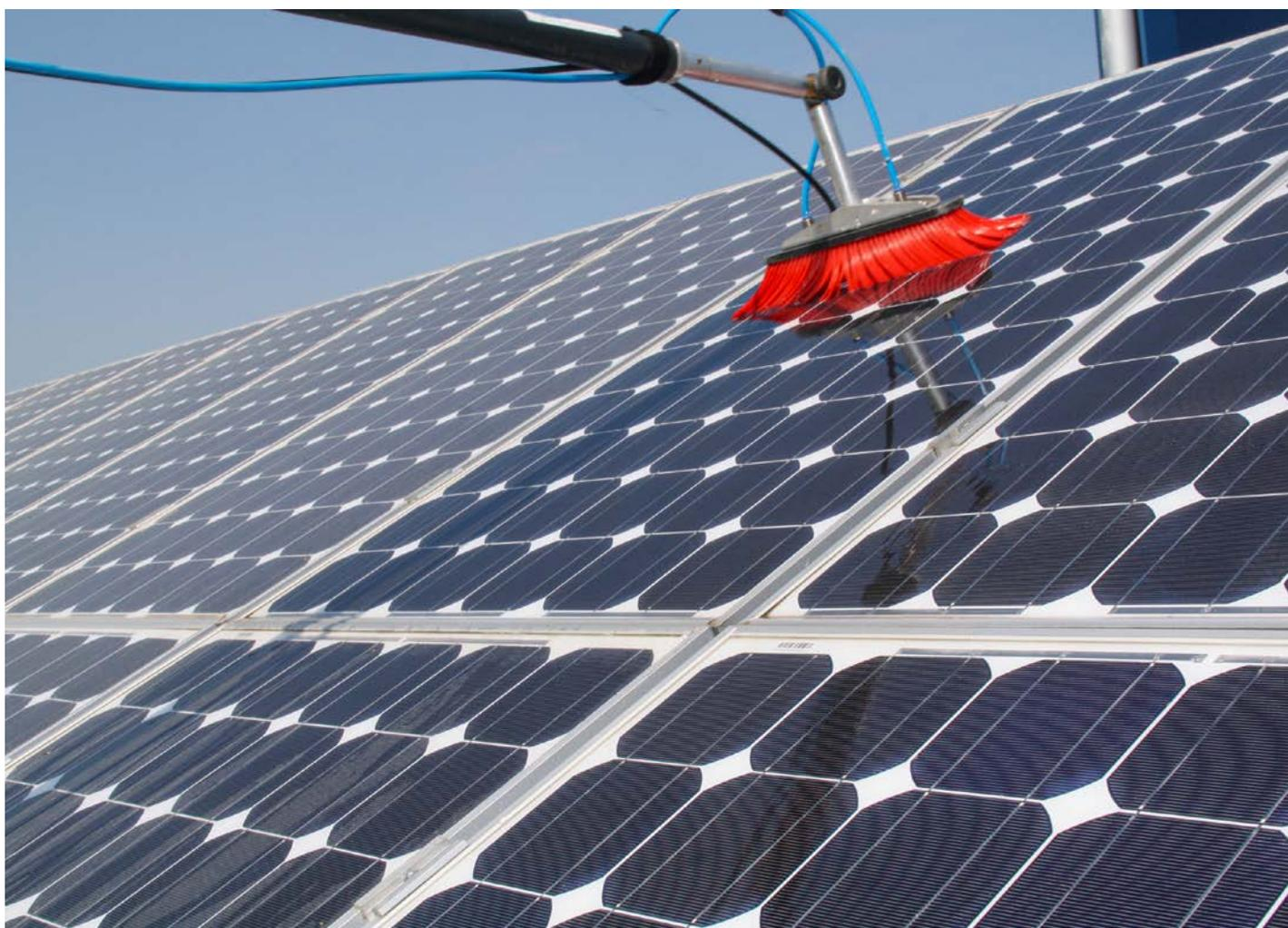
Die Reinigung der Solarmodule ist Fachfirmen vorbehalten. Sie lassen sich die Verfahren von den Modulherstellern zertifizieren.
