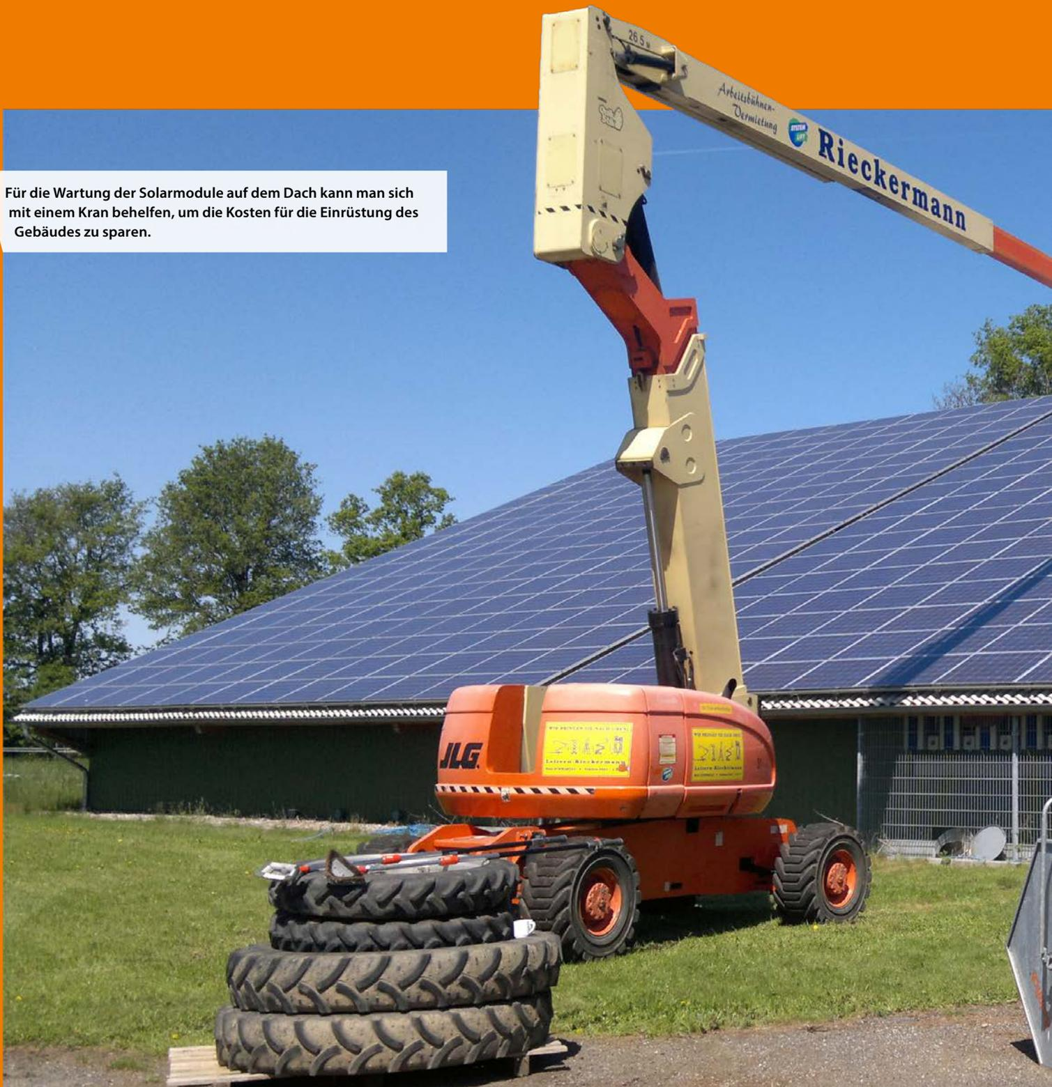
Solargeneratoren sind wartungsfrei: Jahrelang wurde dieses Märchen verbreitet. Die Realität sieht anders aus. Mindestens einmal im Jahr sollte der Generator auf dem Grundstück oder auf dem Dach von einem Fachmann durchgesehen werden. Das Frühjahr ist die beste Zeit, um den Generator fit für die nächste Sonnenperiode zu machen.
