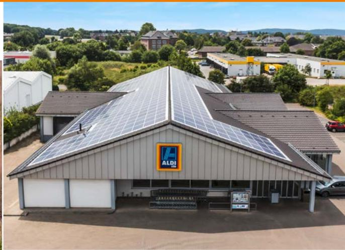
Beispiel einer gewerblichen Photovoltaikanlage auf dem Dach eines Supermarktes. Hier wird der Sonnenstrom vor allem für die Kühlung und die Beleuchtung benötigt.
