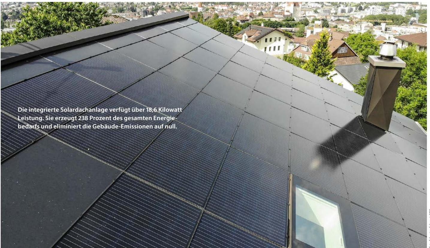
Die integrierte Solardachanlage verfügt über 18,6 Kilowatt Leistung. Sie erzeugt 238 Prozent des gesamten Energiebedarfs und eliminiert die Gebäude-Emissionen auf null.
