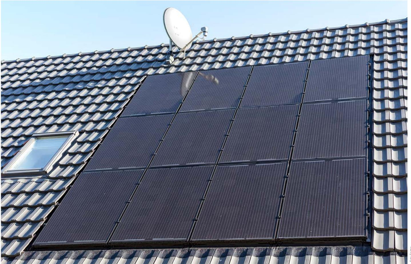
Die Indachanlage eignet sich auch für größere Dachflächen auf Ein- und Zweifamilienhäusern. Die schwarzen Solarmodule von der Sonnenstromfabrik in Wismar lassen sich ins Ziegeldach integrieren und sorgen für eine einheitliche Oberfläche. Mit der ins Dach integrierbaren Anlage bietet Creaton eine optisch reizvolle Möglichkeit, Photovoltaik zu nutzen.
