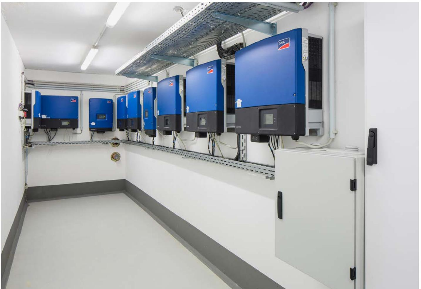
Die Wechselrichter einer größeren Solaranlage: Sonnenstrom lässt sich gut verwenden, um Wärmepumpen zu versorgen.
