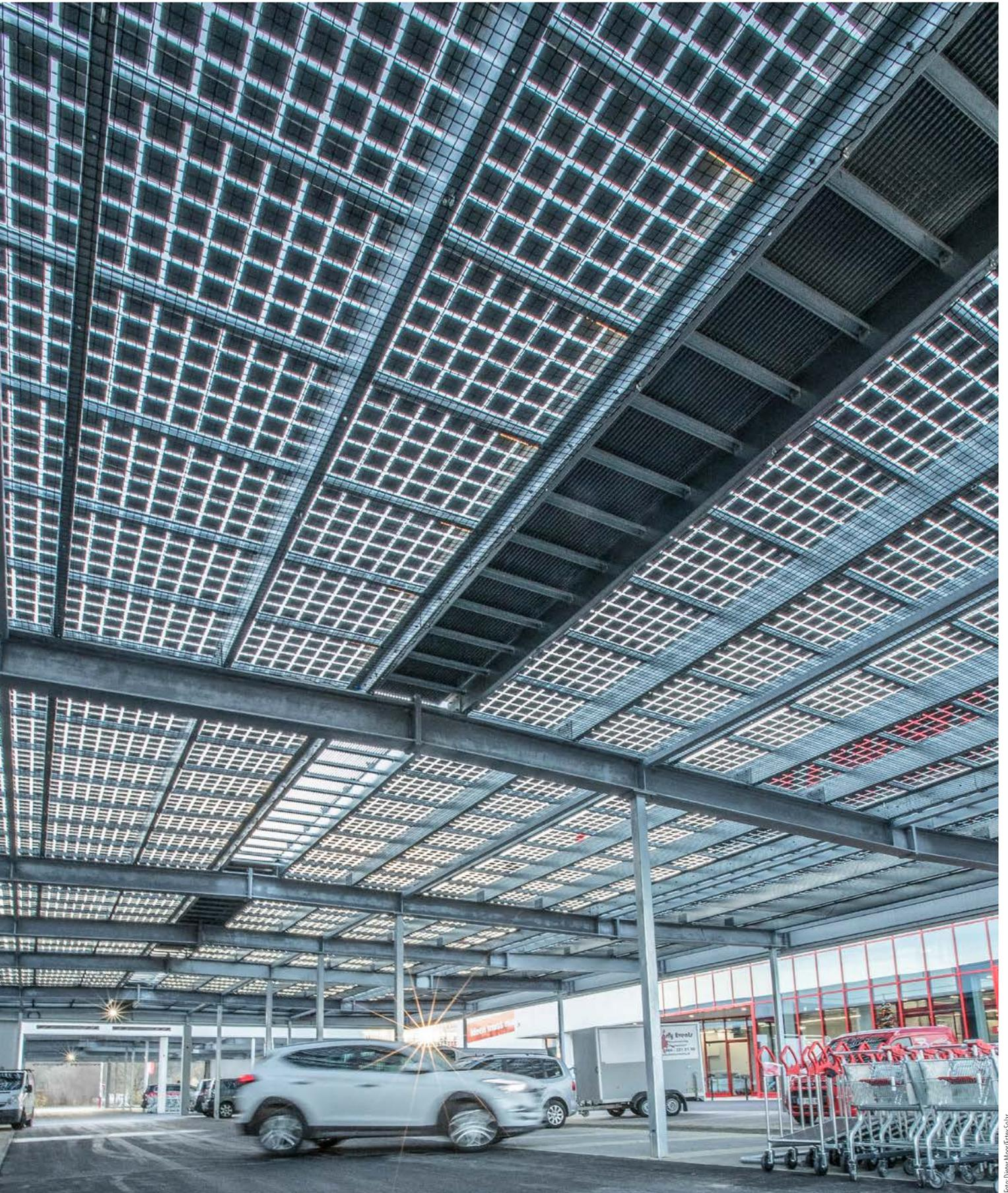
**Solare Wärme mitgedacht:** Der neu errichtete Hellweg-Baumarkt im österreichischen Fürstenfeld hat einen solar überdachten Parkplatz. Die 644 semitransparenten Module auf 2.300 Quadratmetern Fläche erreichen 270 Kilowatt Leistung. Was man nicht sieht: Eine Luft-Wasser-Wärmepumpenanlage übernimmt dank des Solarstroms mehr als 80 Prozent der Wärmeversorgung.
