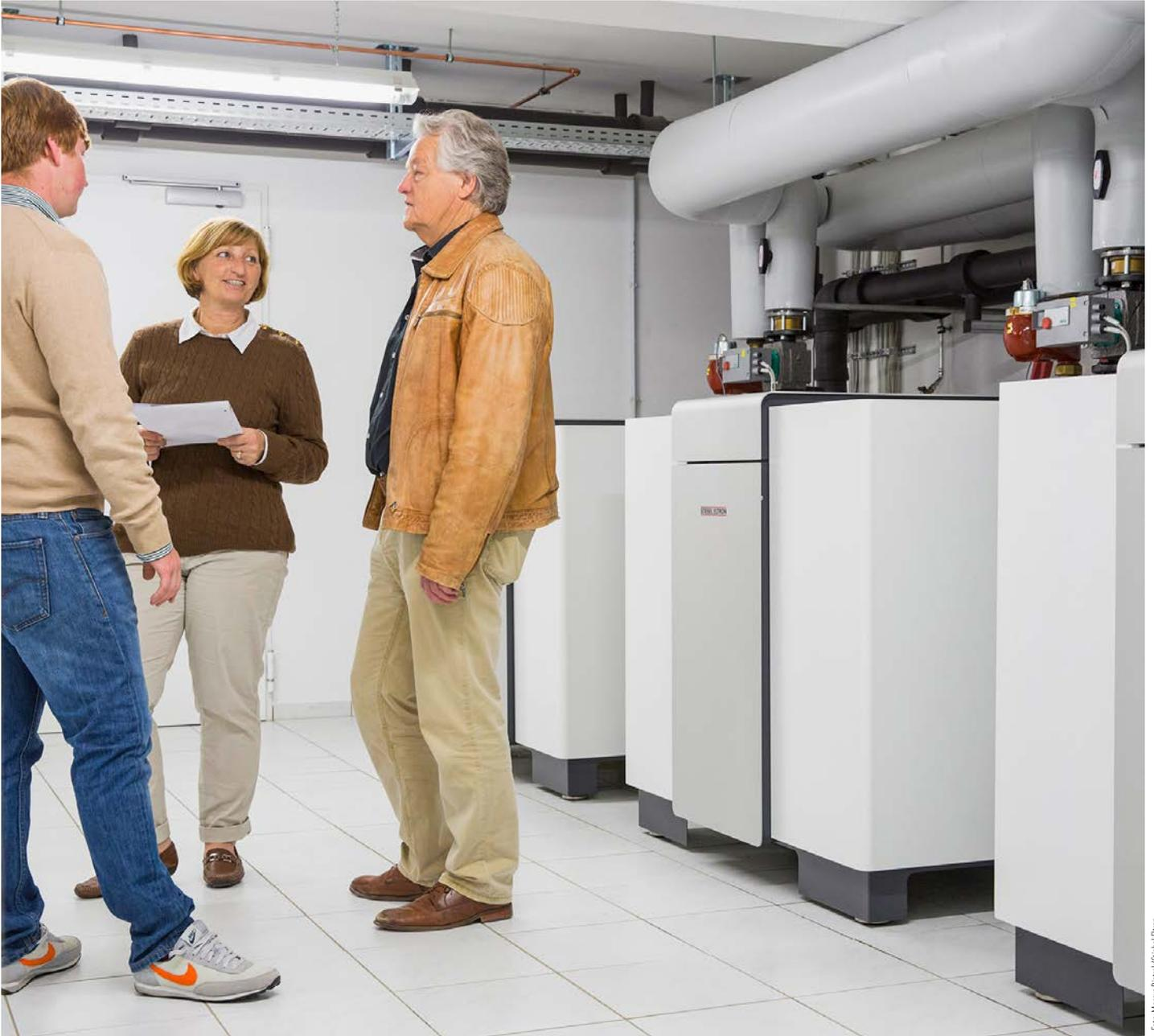
**Wärmepumpen lassen sich sehr gut in Kaskaden schalten. Man sollte jedoch stets die Wärmeerzeugung für Warmwasser und Raumwärme trennen.**
