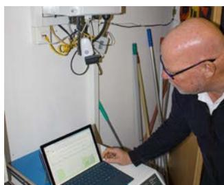
**Inbetriebnahme eines Heimspeichers bei einer Familie in Südhessen. Der Installateur schließt den Laptop an und stellt die Parameter ein.**
