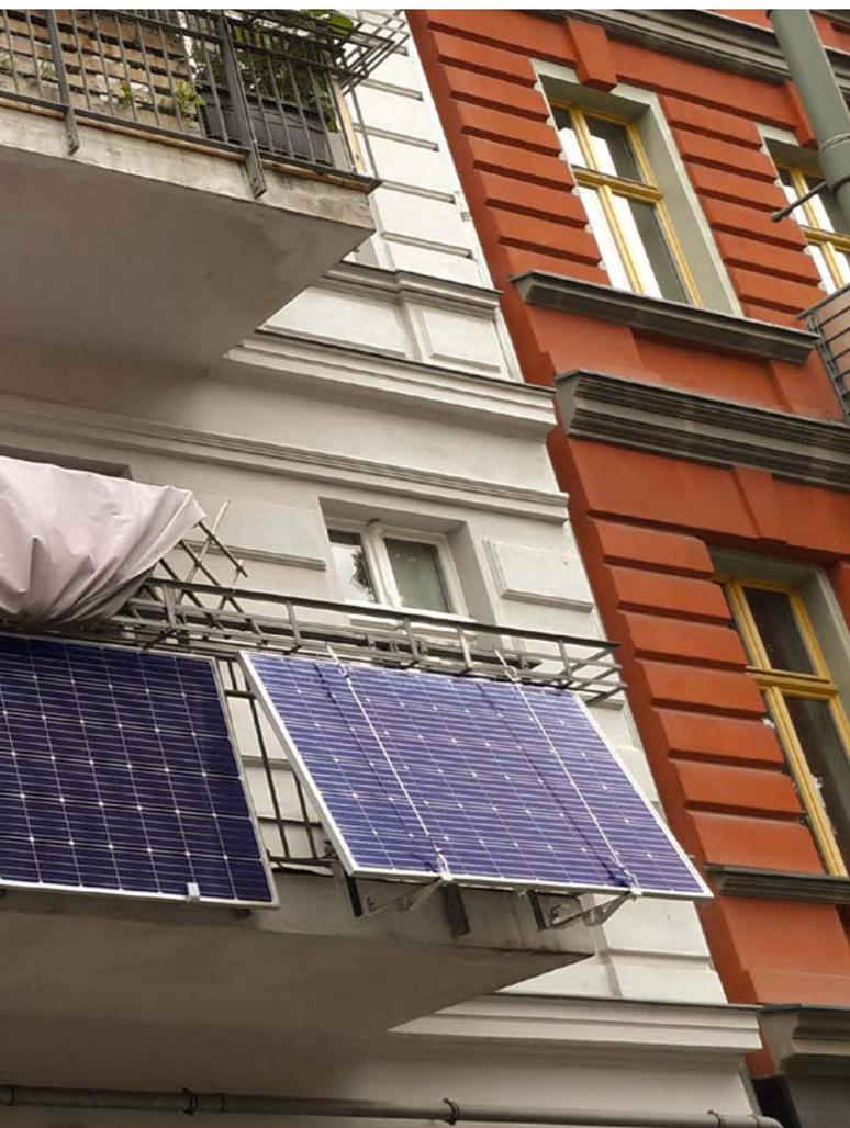
teurer machen als vom Ökostromversorger. Denn: Senkrecht am Balkon angebrachte Solarmodule nutzen im besten Fall nur rund 70 bis 80 Prozent ihrer elektrischen Nennleistung, weil sie nicht optimal zur Sonne stehen. Das gilt für alle vertikalen Installationen an Fassaden oder Balkonen.
